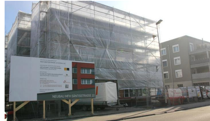
Der Neubau MFH Sântisstrasse 22 ist ein Erweiterungsprojekt der VitaTertia für bedürftigere Wohnformen. sj
